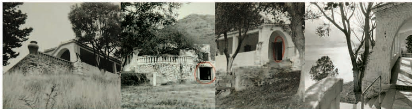
Fotografías tomadas durante la inspección de CONADEP en 1984 con distintas vistas de la casa de Hidráulica 23 .
