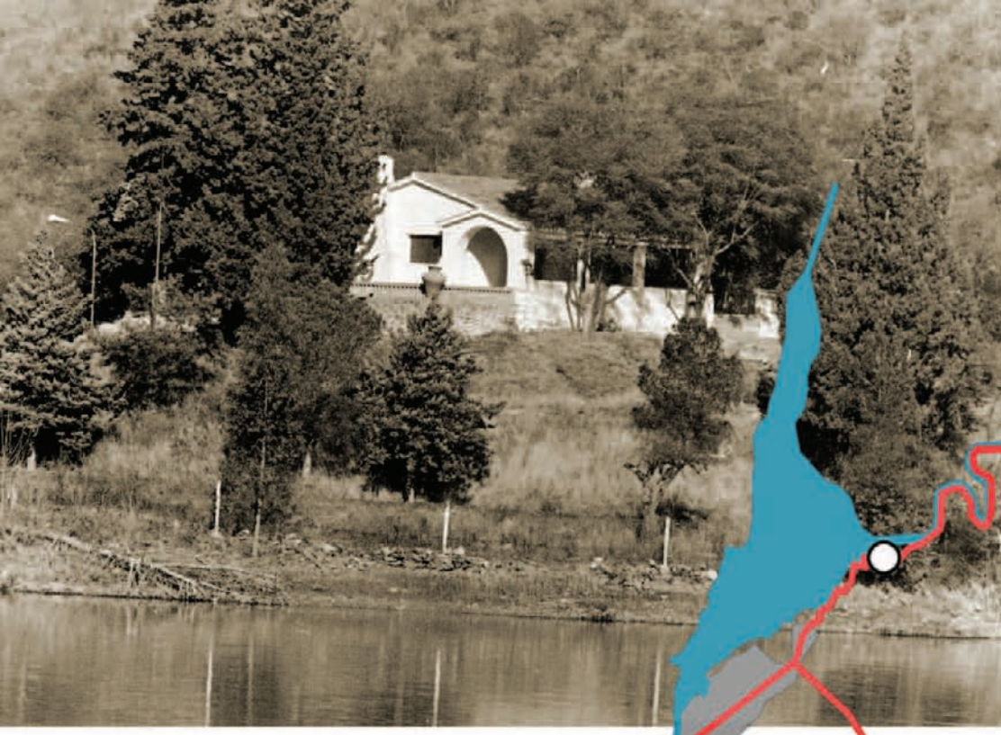
Chalet de Hidráulica
