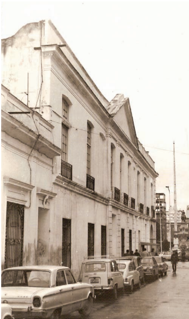
Vista del pasaje en los 70'. Los autos llegaban hasta la puerta del D2
