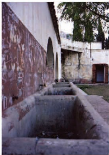
Piletones de la vieja cárcel que siguen funcionando como bebederos en el patio del colegio.
