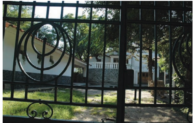
Desde el portón se distinguen la construcción nueva y la vieja. Entre ellas una galería abierta.
